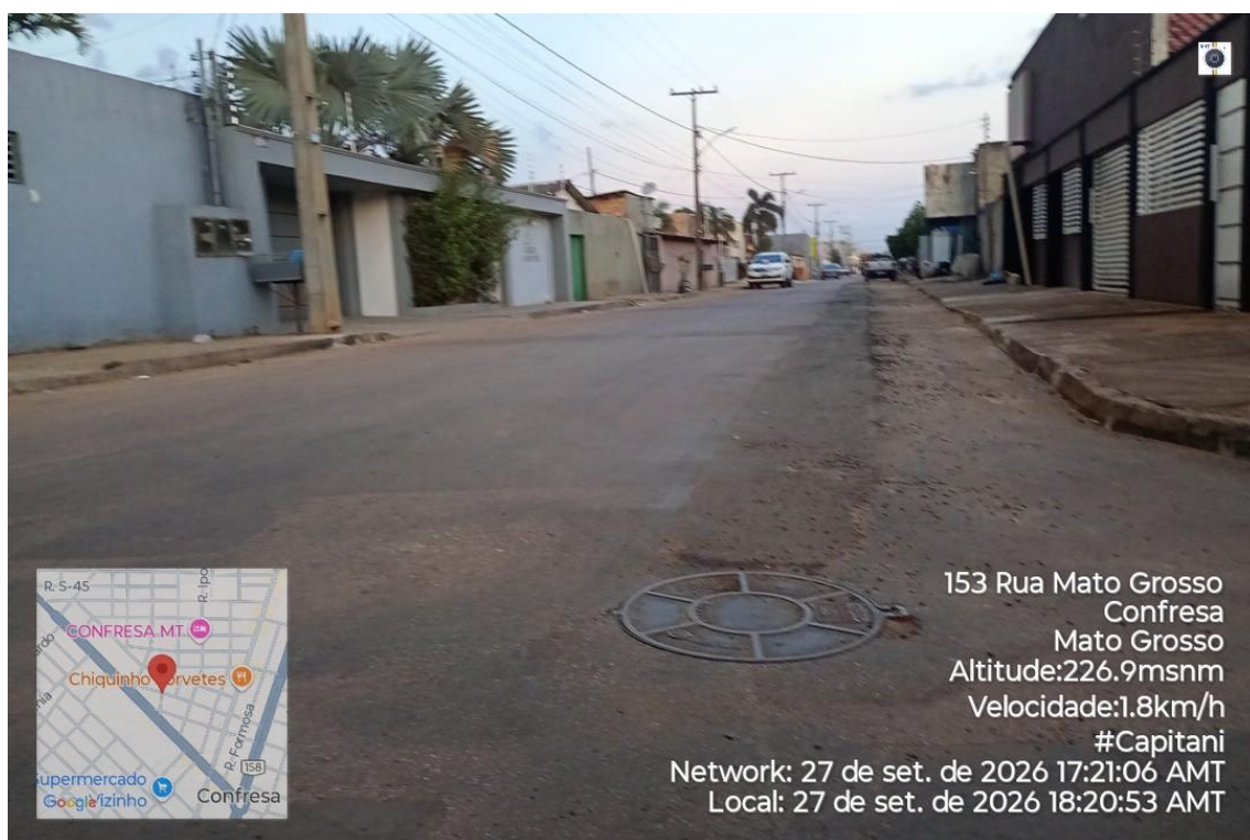
Figura 41 - Obras de implantação de rede de esgoto – repavimentação asfáltica
