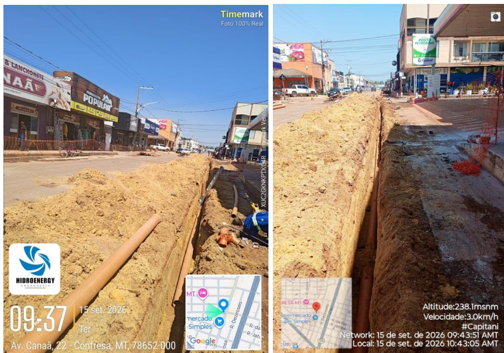
Figura 7 - Obras de implantação de rede de esgoto
