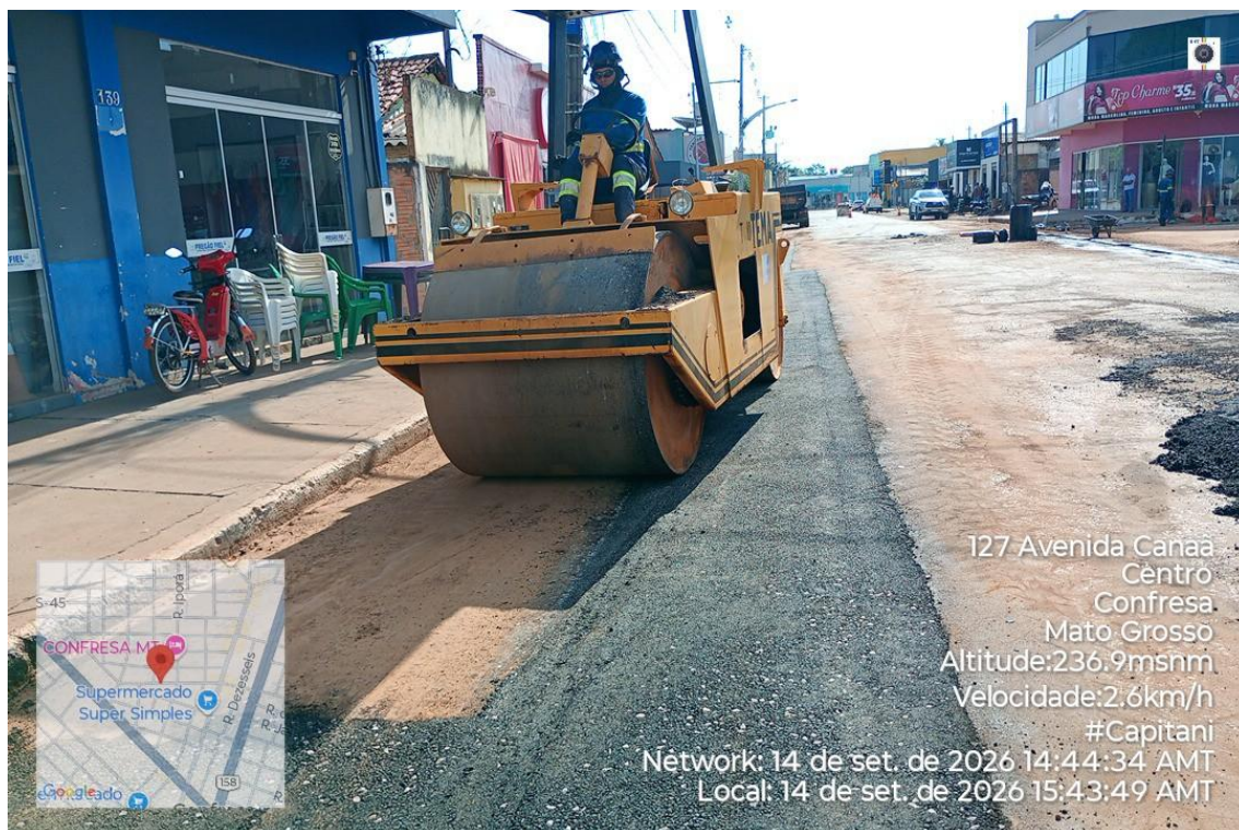
Figura 29 - Obras de implantação de rede de esgoto
