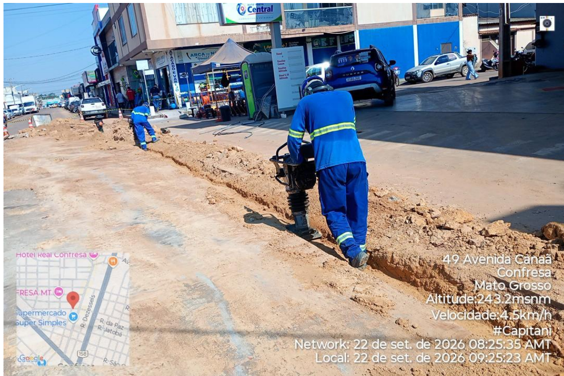
Figura 14 - Obras de implantação de rede de esgoto
