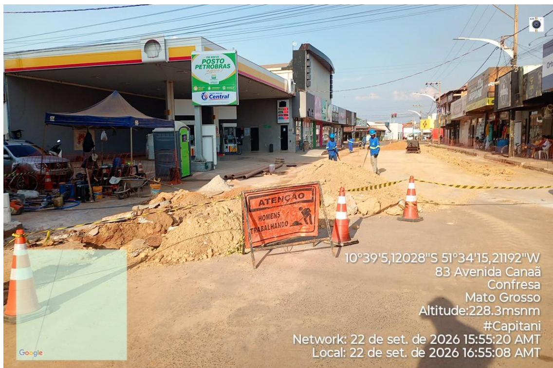
Figura 15 - Obras de implantação de rede de esgoto
