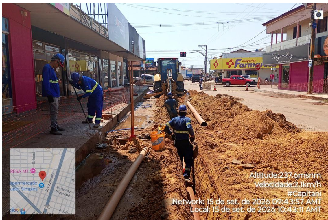
Figura 10 - Obras de implantação de rede de esgoto
