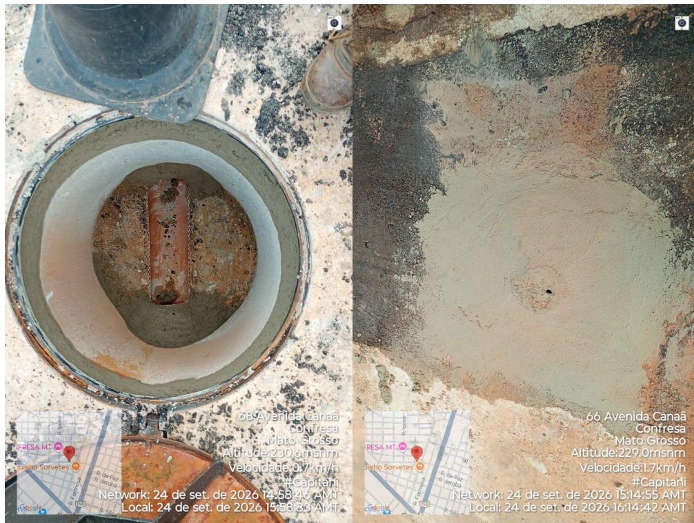
Figura 26 - Obras de implantação de rede de esgoto
