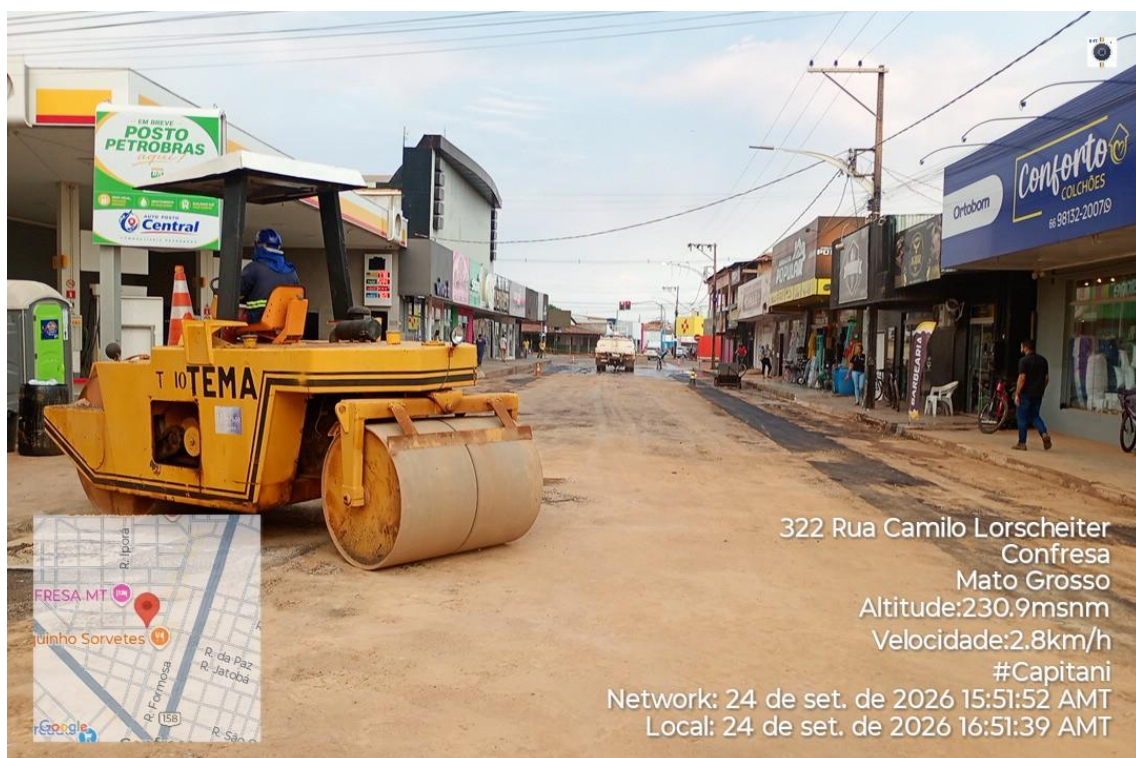
Figura 27 - Obras de implantação de rede de esgoto
