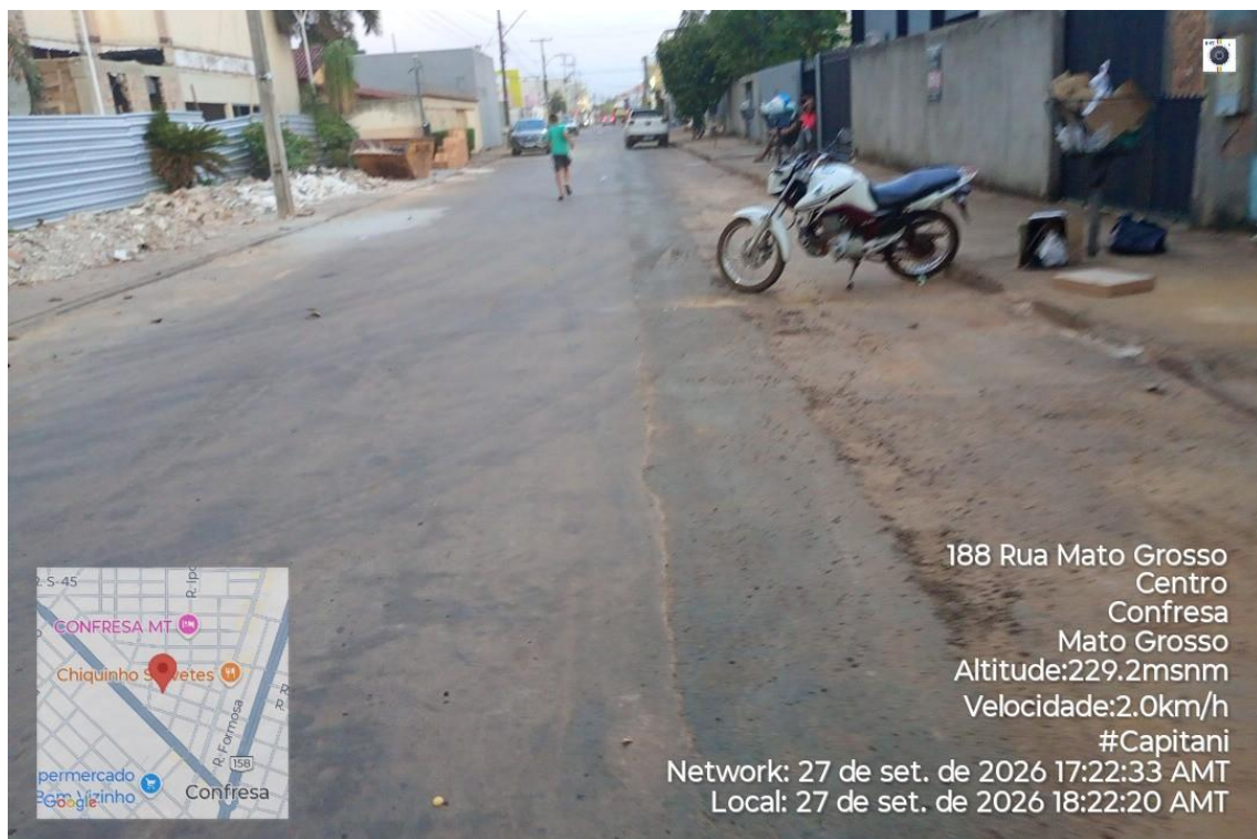
Figura 35 - Obras de implantação de rede de esgoto – repavimentação asfáltica
