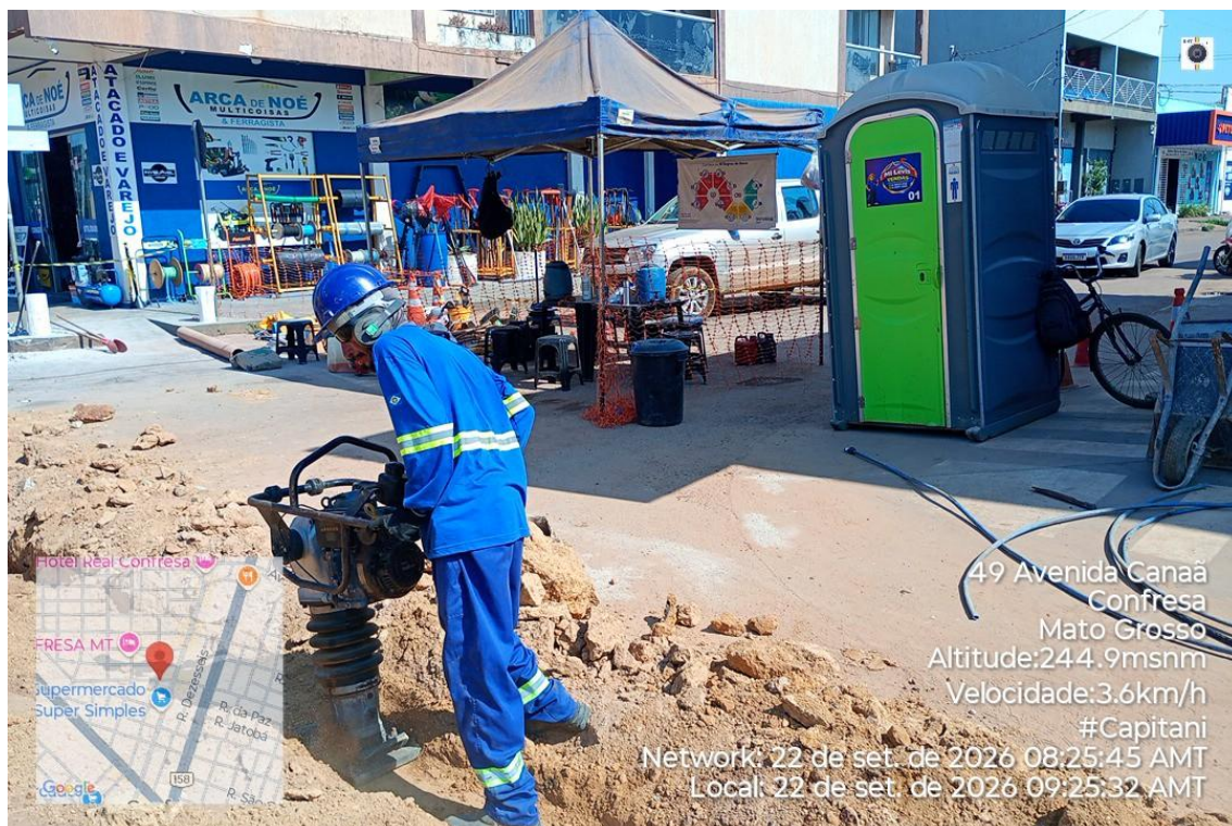
Figura 17 - Obras de implantação de rede de esgoto
