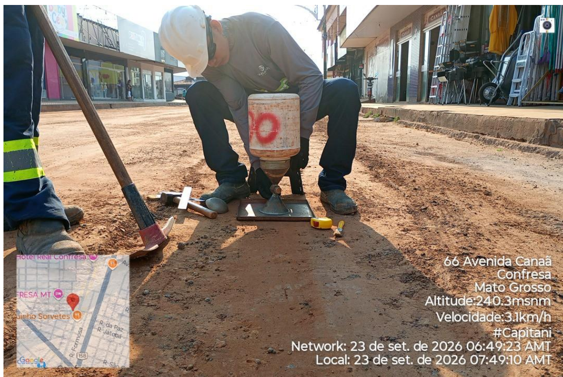
Figura 19 - Obras de implantação de rede de esgoto
