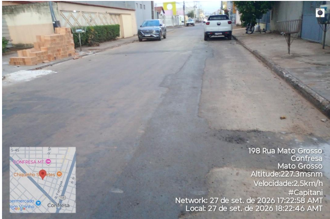
Figura 34 - Obras de implantação de rede de esgoto – repavimentação asfáltica
