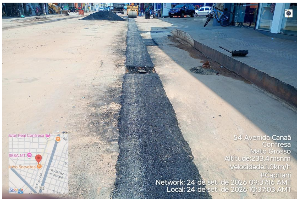
Figura 22 - Obras de implantação de rede de esgoto
