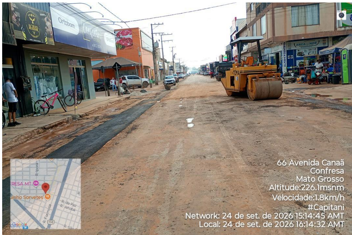
Figura 31 - Obras de implantação de rede de esgoto – repavimentação asfáltica
