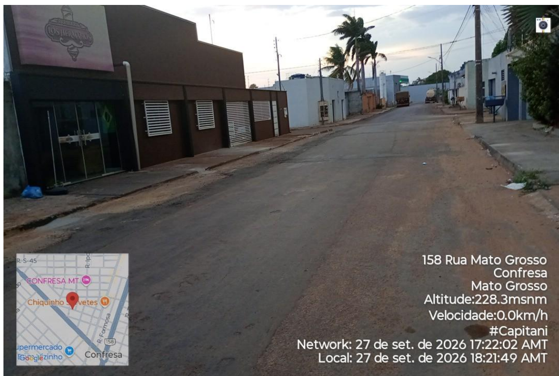
Figura 38 - Obras de implantação de rede de esgoto – repavimentação asfáltica
