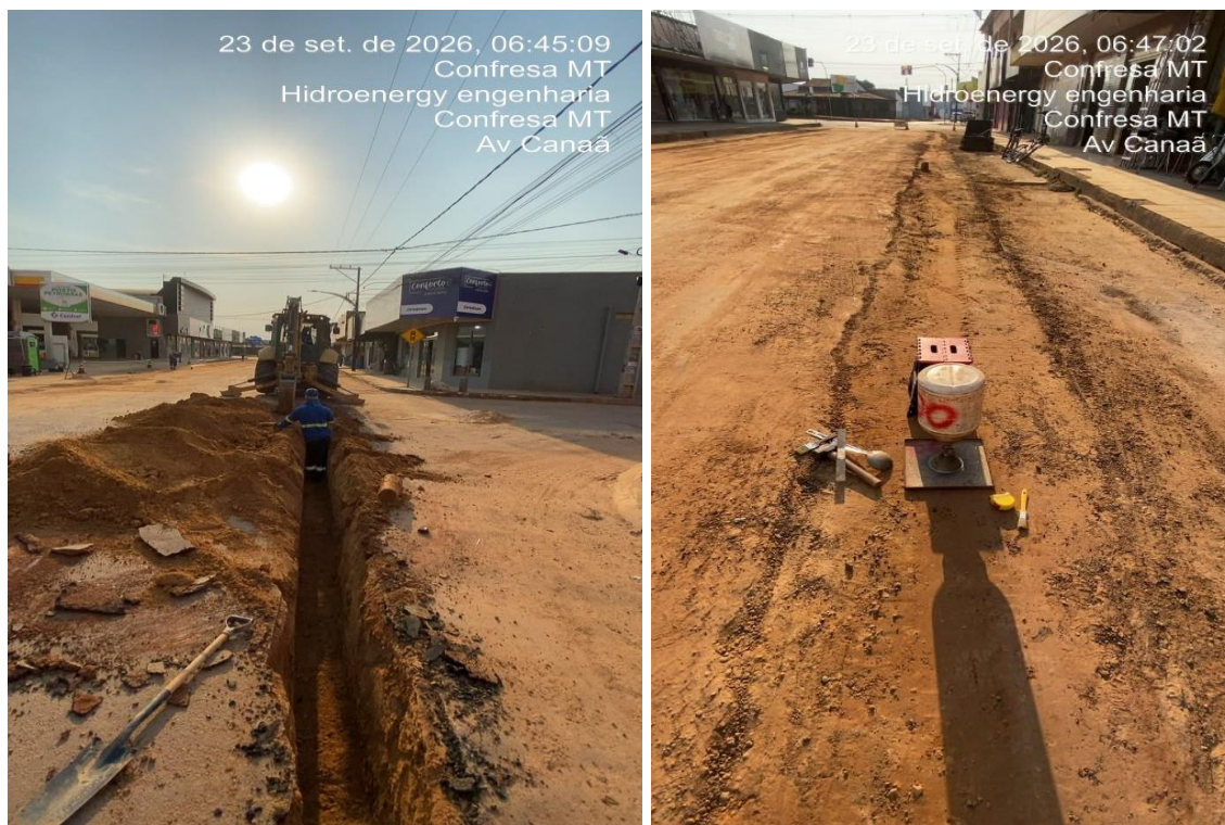
Figura 13 - Obras de implantação de rede de esgoto
