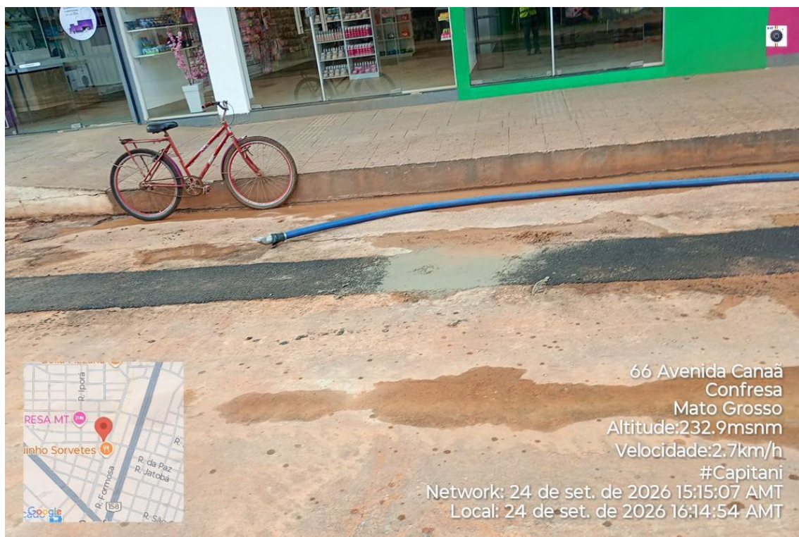
Figura 32 - Obras de implantação de rede de esgoto – repavimentação asfáltica
