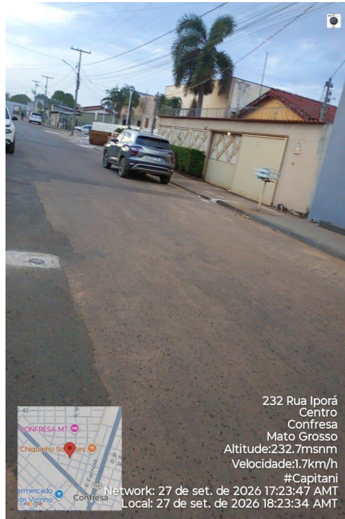
Figura 42 - Obras de implantação de rede de esgoto – repavimentação asfáltica
