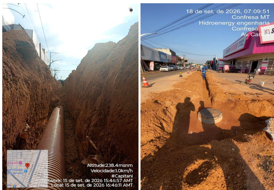
Figura 11 - Obras de implantação de rede de esgoto
