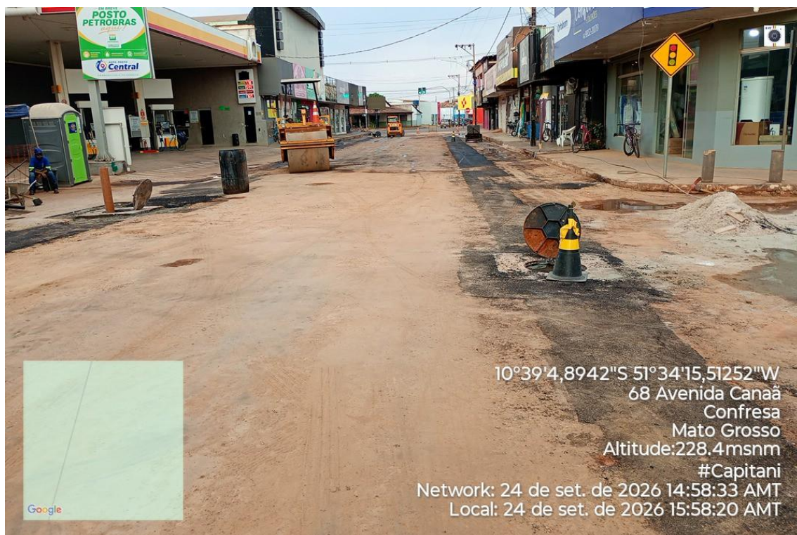
Figura 28 - Obras de implantação de rede de esgoto
