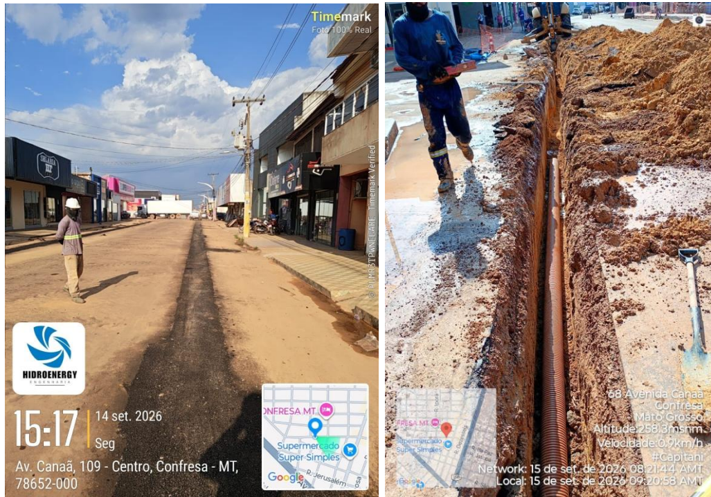
Figura 6 - Obras de implantação de rede de esgoto
