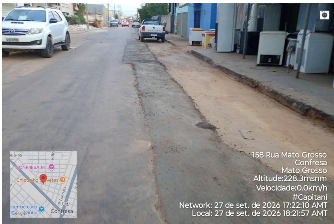
Figura 40 - Obras de implantação de rede de esgoto – repavimentação asfáltica
