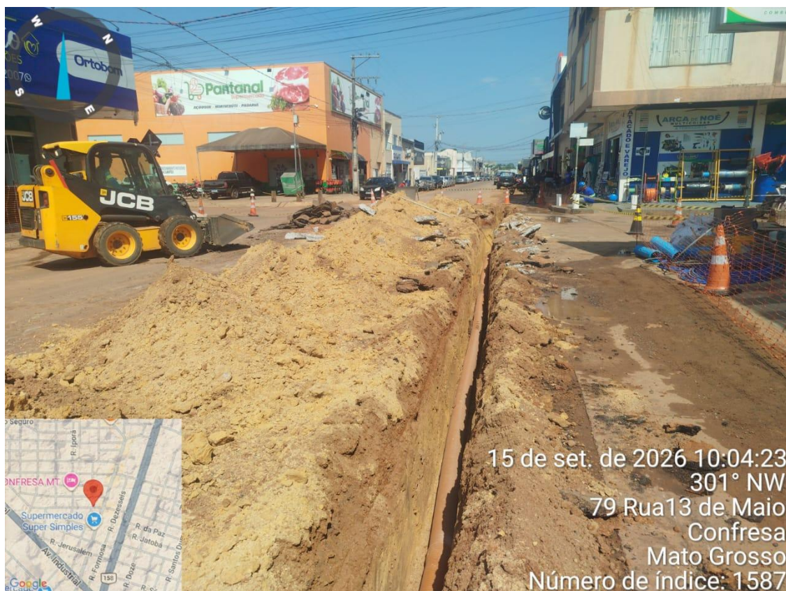
Figura 8 - Obras de implantação de rede de esgoto
