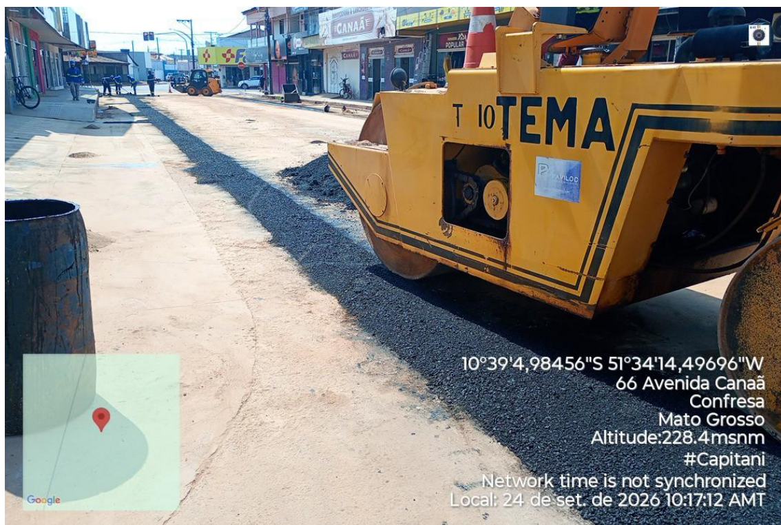
Figura 20 - Obras de implantação de rede de esgoto
