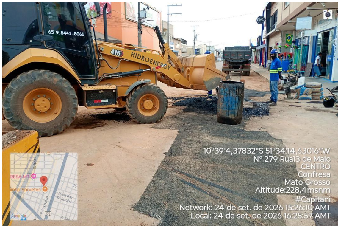
Figura 25 - Obras de implantação de rede de esgoto
