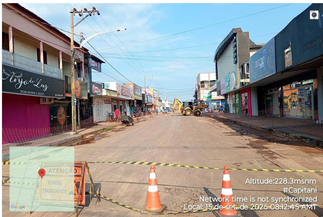
Figura 5 – Obras de implantação de rede de esgoto
