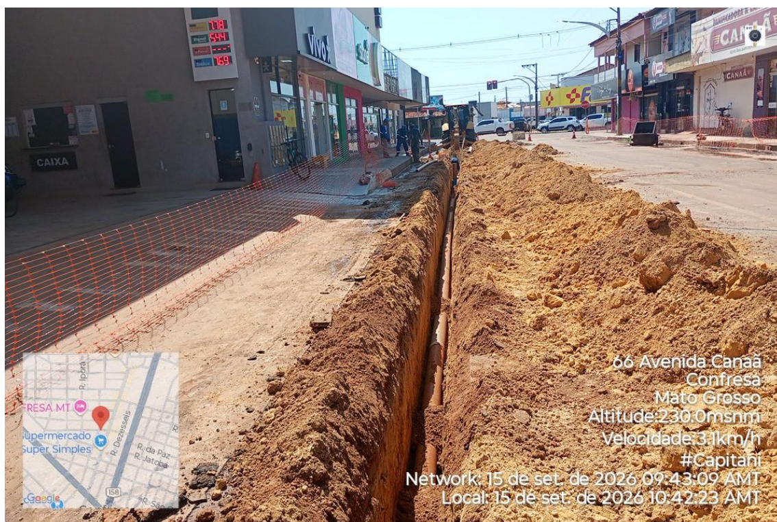
Figura 9 - Obras de implantação de rede de esgoto
