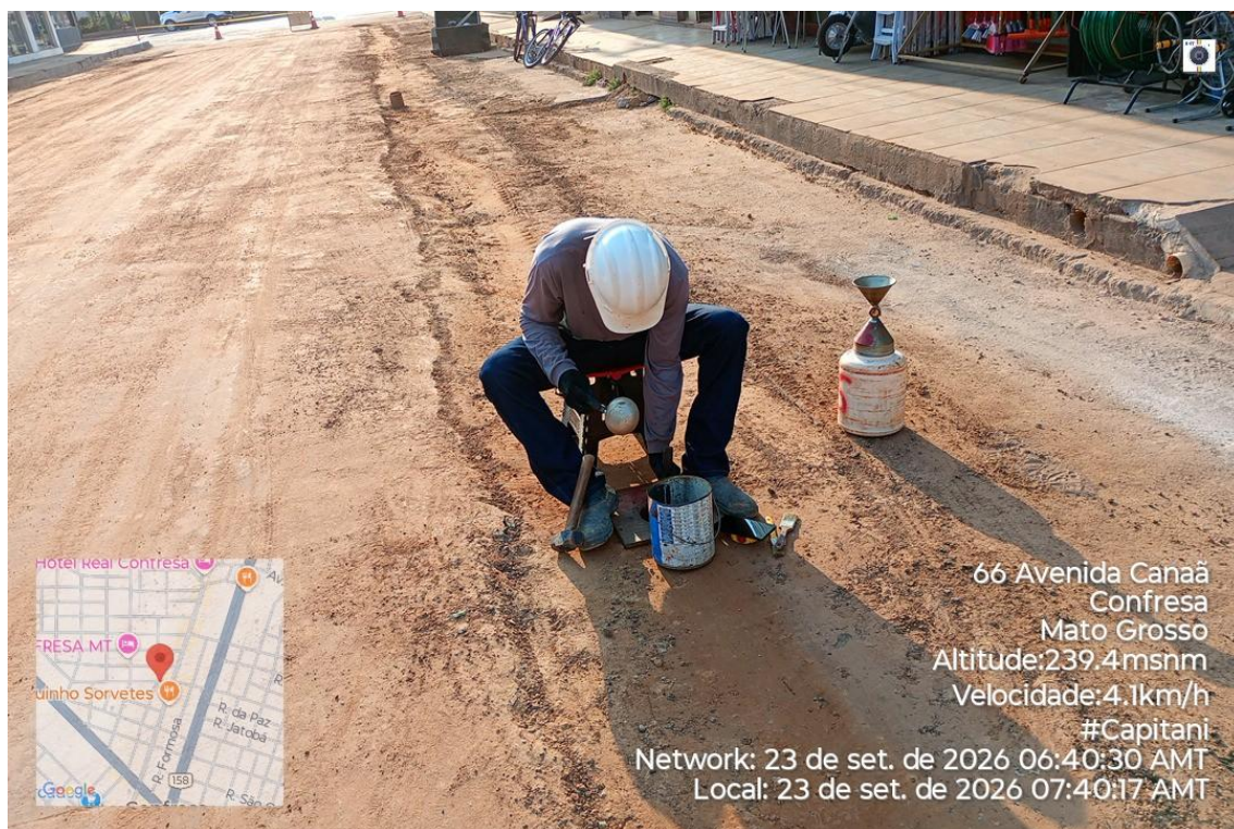
Figura 18 - Obras de implantação de rede de esgoto
