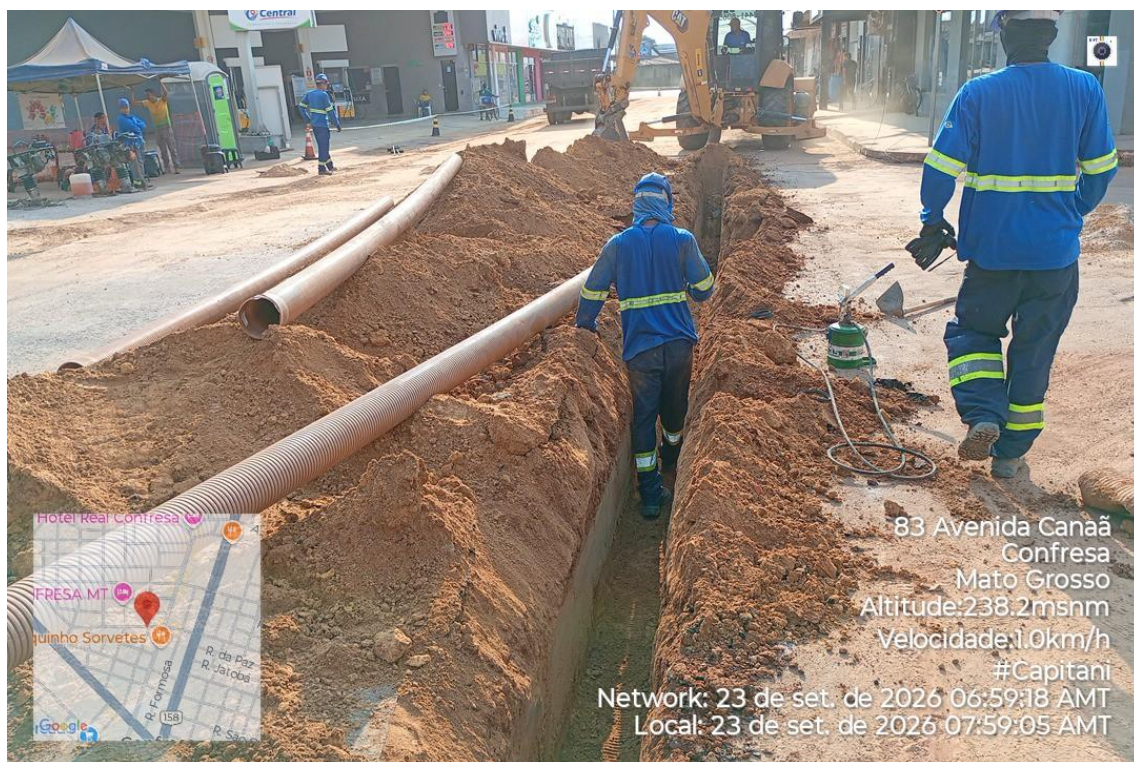
Figura 16 - Obras de implantação de rede de esgoto
