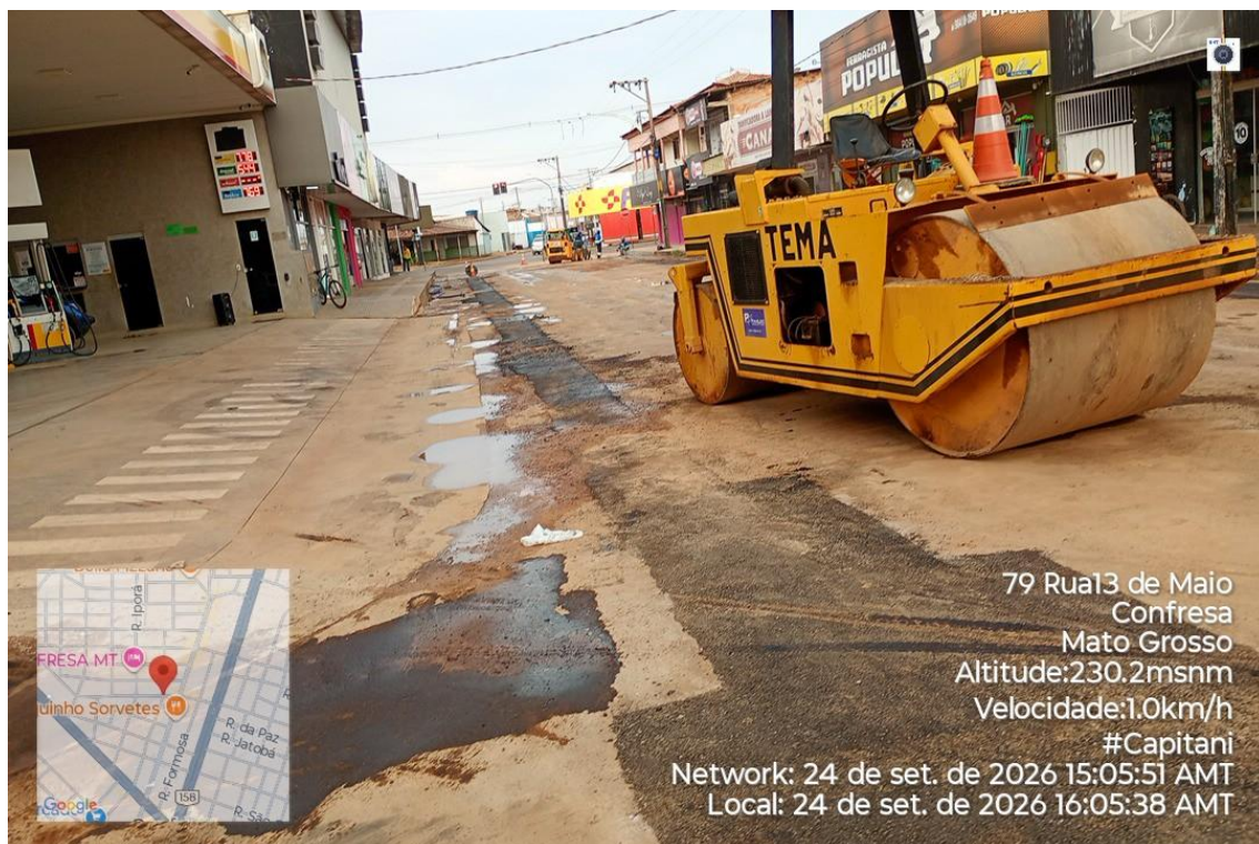
Figura 23 - Obras de implantação de rede de esgoto
