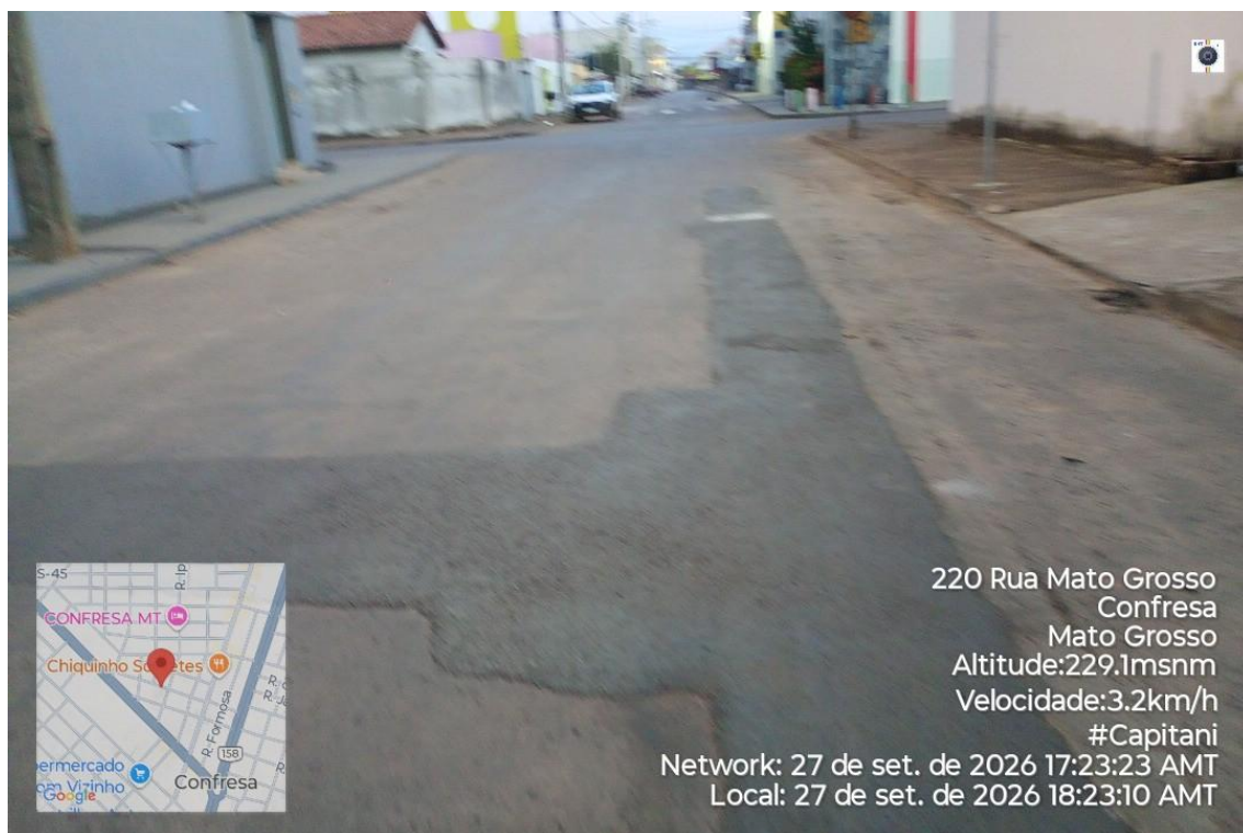
Figura 33 - Obras de implantação de rede de esgoto – repavimentação asfáltica
