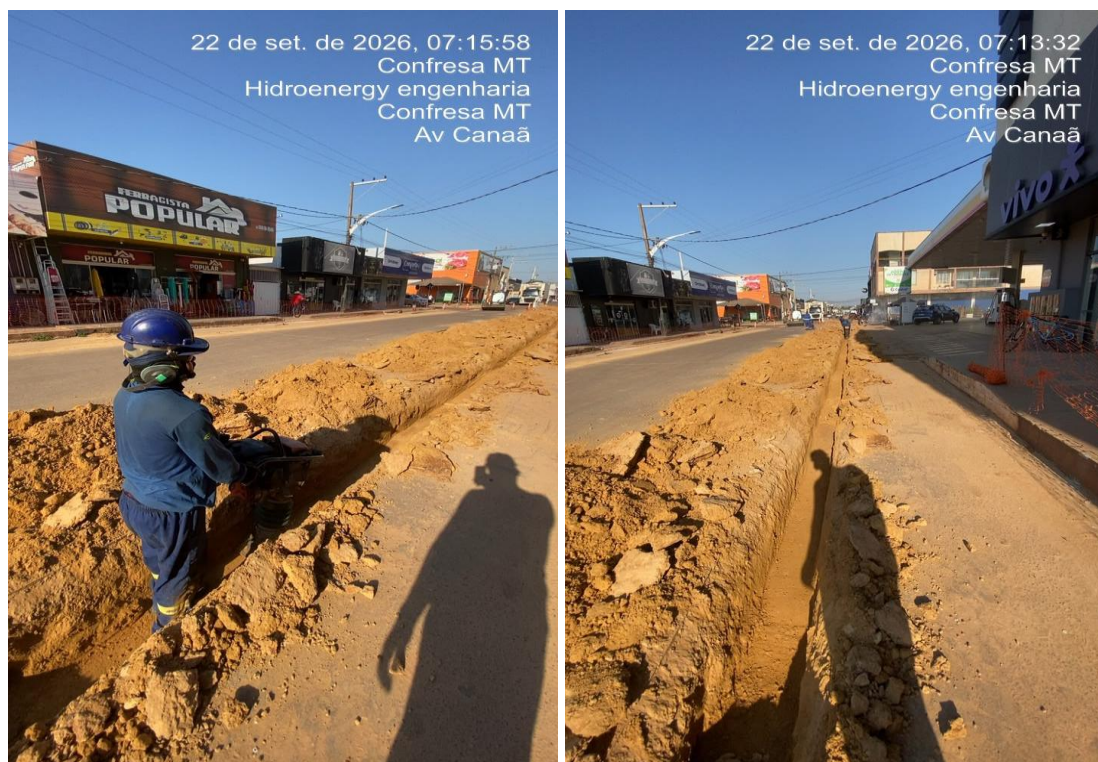
Figura 12 - Obras de implantação de rede de esgoto
