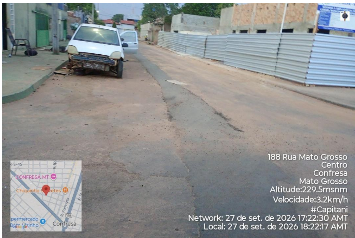
Figura 36 - Obras de implantação de rede de esgoto – repavimentação asfáltica
