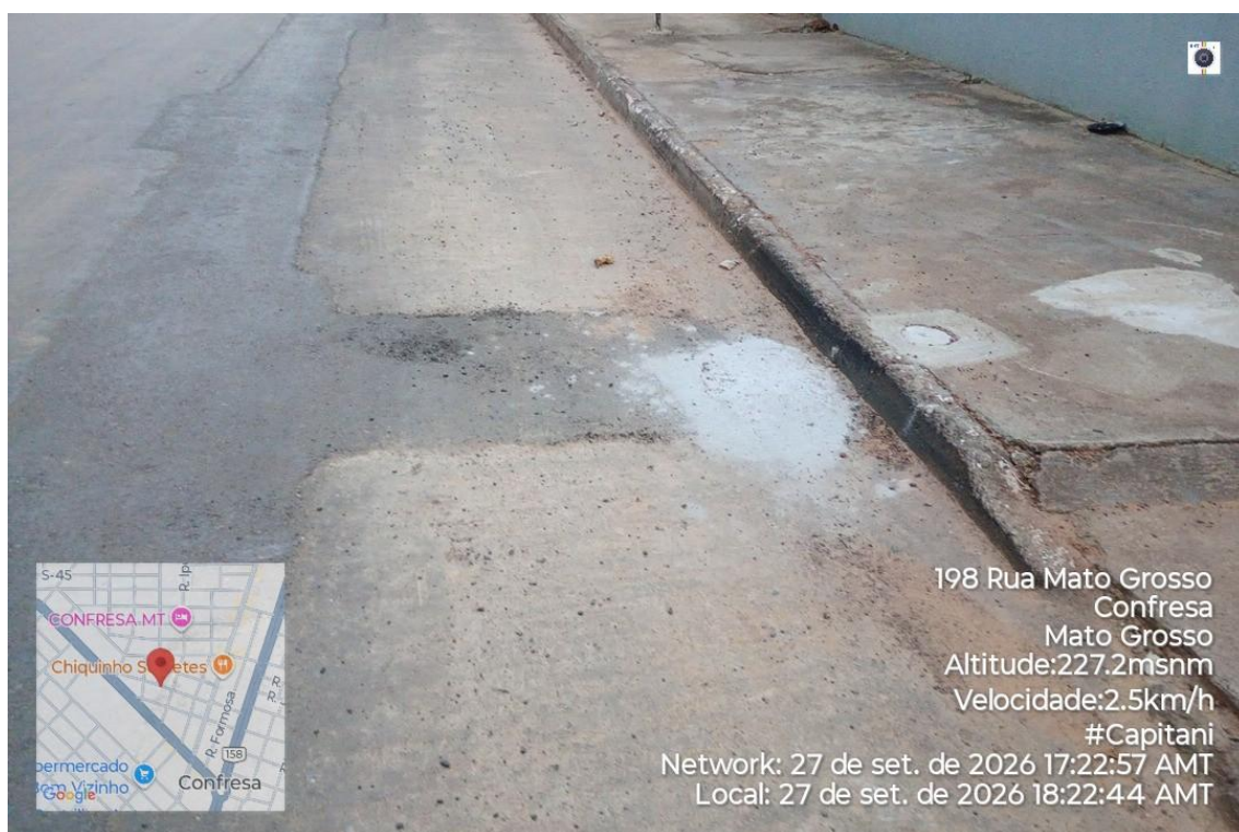
Figura 37 - Obras de implantação de rede de esgoto – repavimentação asfáltica
